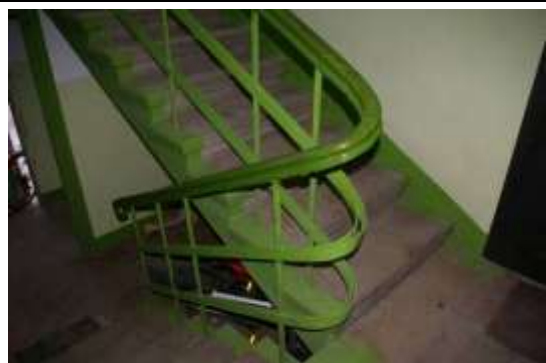
Dzīvojamā ēka ar kadastra apzīmējumu 1700 021 0115 001, koplietošanas telpa
